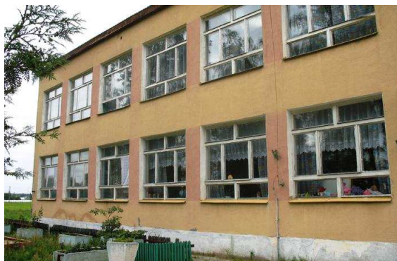
Budynek szkoły podstawowej
