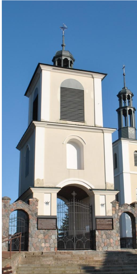
Ryc. 7. Dzwonnica przy kościele w Lipnikach; fot. Edyta A. Marek
